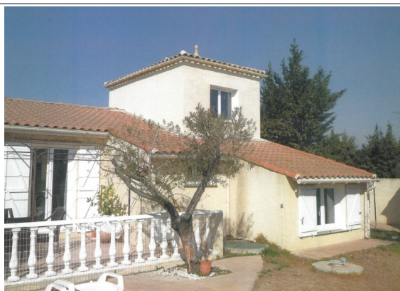
Création d'un espace refuge sur une extension dont le rez-de-chaussée a été laissé ouvert (face avant et face arrière)
