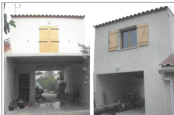
Création d'un espace refuge sur une extension dont le rez-de-chaussée a été laissé ouvert (face avant et face arrière)
